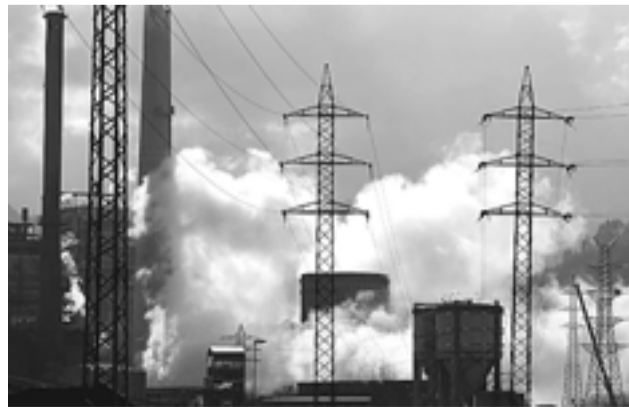
Central térmica de Lada en Langreo (Asturias). EFE/J. L. CERREJIDO
